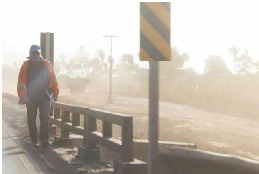
16. Operário em meio à densa poeira causada pelas obras de duplicação.
