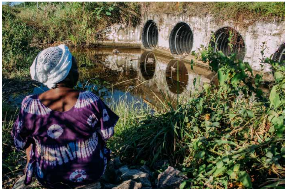
10. Imagem do progresso: igarapé encanado e assoreado para construção da Estrada de Ferro Carajás. Foto: Andressa Zumpano
