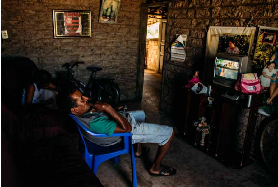
2. A casa de taipa foi construída por seu Zé. Agora está avariada pela ação do DNIT, e periga não aguentar mais um período de chuva.
